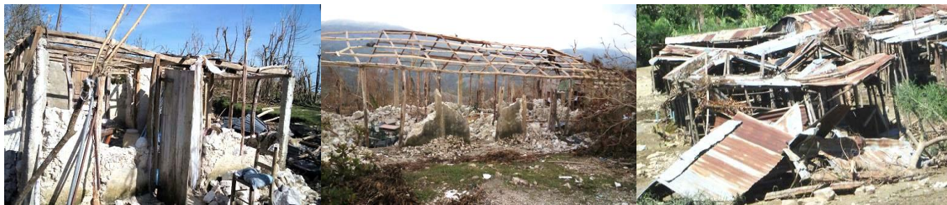
Maisons, écoles, marchés, etc. l'habitat et les édifices communautaires ont également été lourdement endommagés par Matthew et Irma. La vie en milieu rural s'en est retrouvée comme arrêtée.
