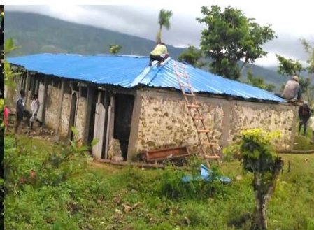
Reconstruction après Matthew d'une école rurale de la Grand'Anse.
